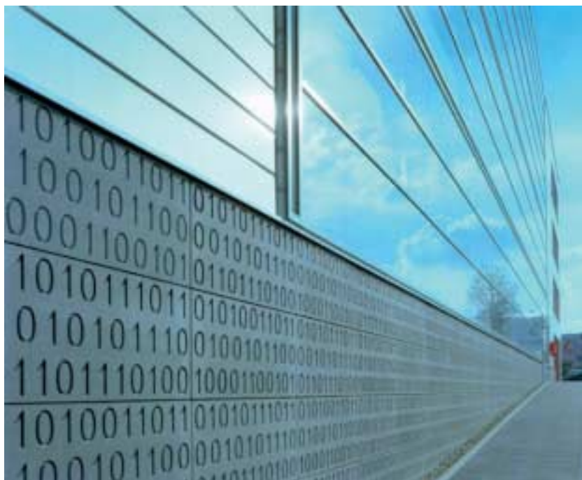
Fig. 7 El hormigón de estos elementos betoShell se coloreó de antracite, y la superficie se chorreó con arena. El código binario estampado en segundo término se realizó con hormigón visto a petición del despacho de arquitectos « Bahl und Partner » de Hagen, Alemania.
