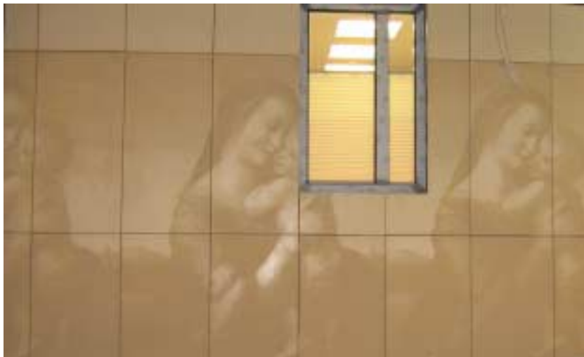
Fig. 8 A finales de 2006 Hering construyó la fachada especial del hospital « Marienkrankenhaus » de Hamburgo. Estos elementos betoShell se suministraron con una imagen superficial estampada de María realizada mediante el llamado « método de hormigón fotograbado », que fue mejorado por la empresa Hering Bau.
