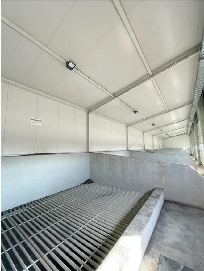
*Silos à granulats avec six compartiments couverts pour le sable et l'argile expansée Liapor*
